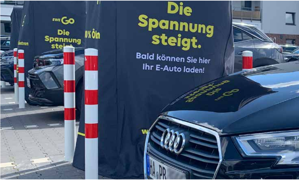
Rammschutzpoller als E-Ladesäulenschutz mit aufgeschweißter Stahlkappe
