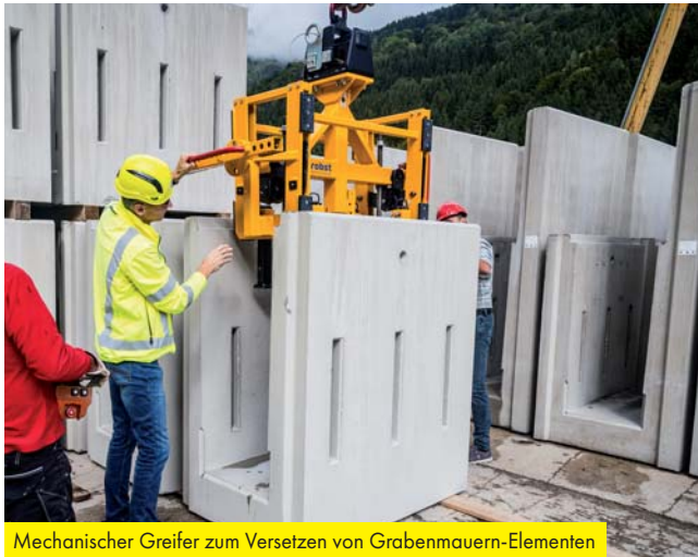
Mechanischer Greifer zum Versetzen von Grabenmauern-Elementen
