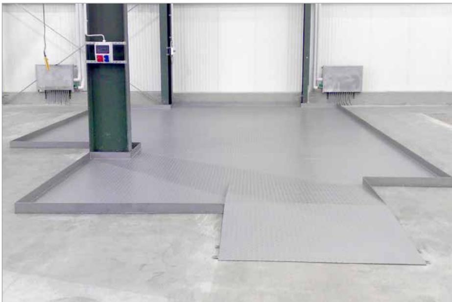
Bodenschutz-Auskleidung mit Aussparung für Pfeiler und Überfahrrampe
